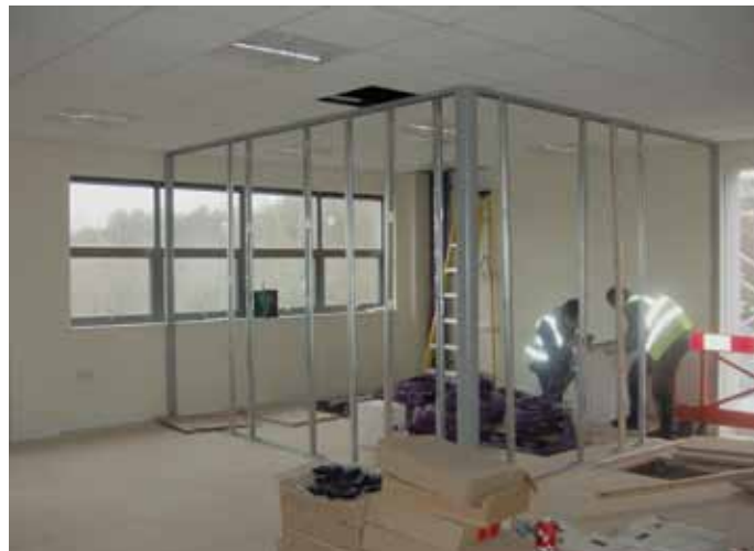
Gradnja strežniške sobe
